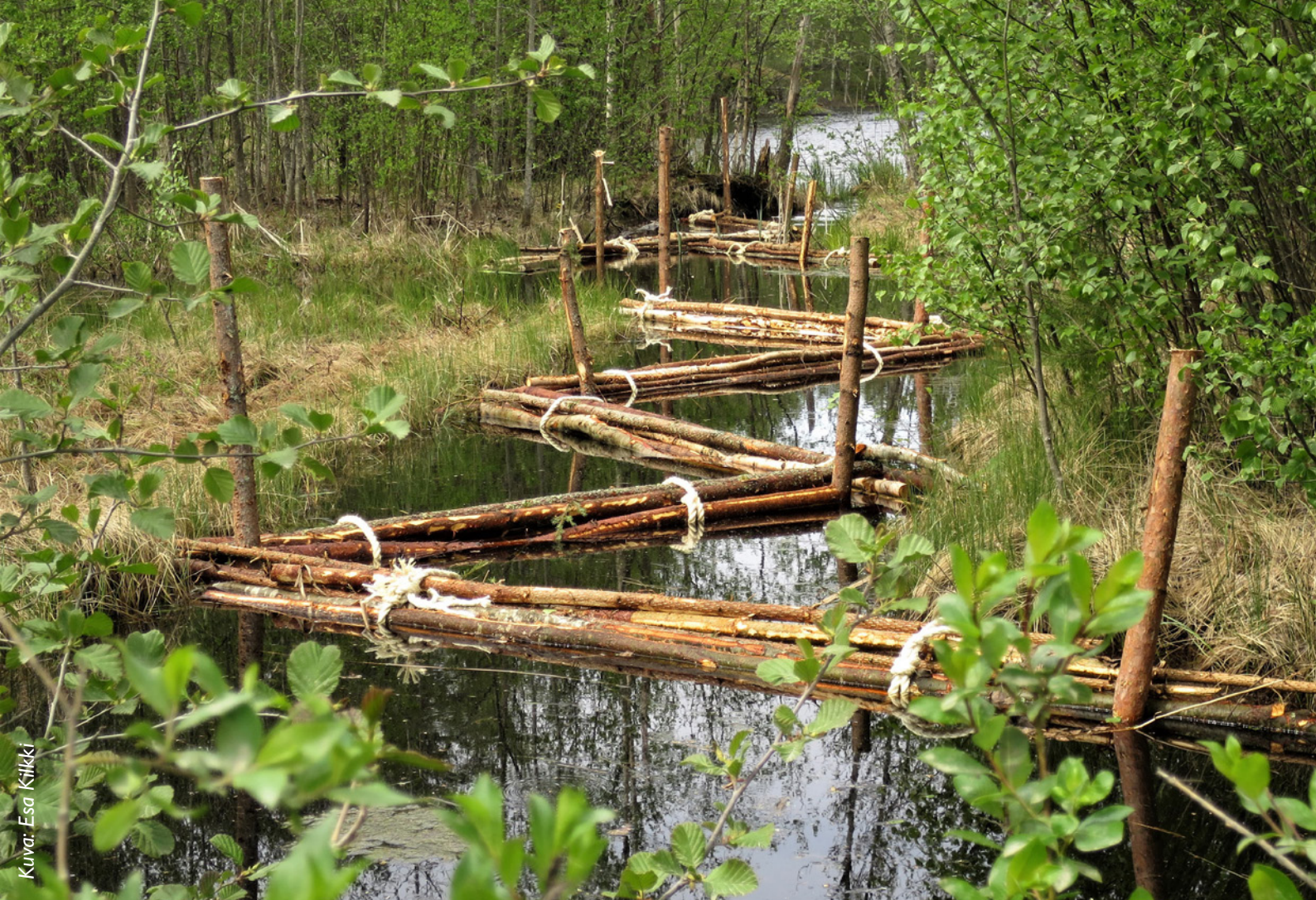
Vesiensuojelutalkoiden puuniput asennettuna odottamaan uppoamista ja biopuhdistamon käynnistymistä. Kattelussaari, Taipalsaari.
